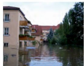
Hochwasser in der Stadt
